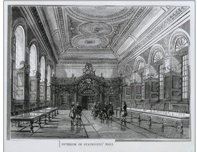
Innenansicht der Stationers Hall (undatiert).
